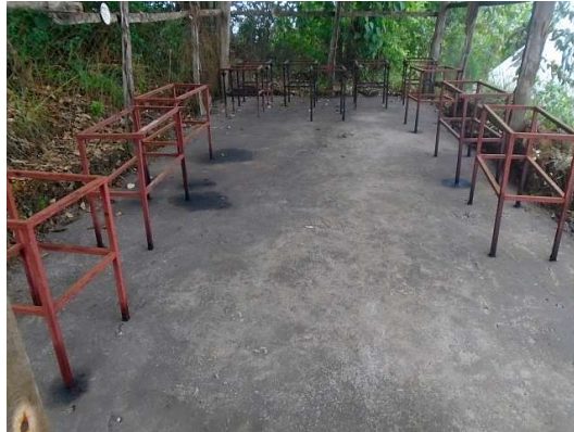
害虫の繁殖防止対策で、 床をセメント施工した 養蜂小屋
