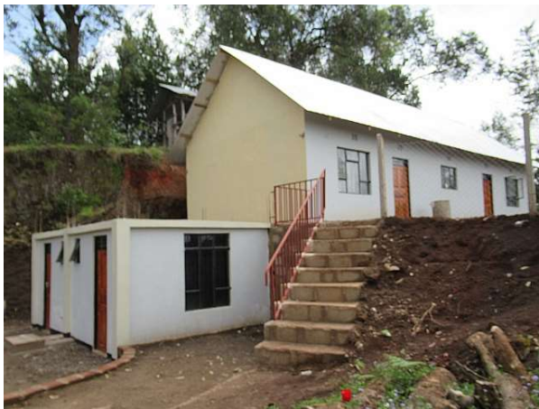
(写真左) 完成した裁縫教室寄宿舎
