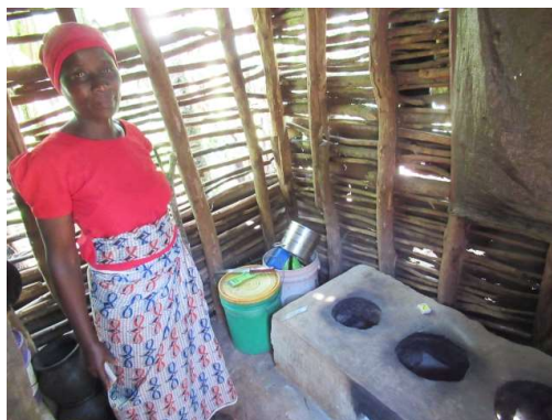
ロレ村に設置された改良カマド
