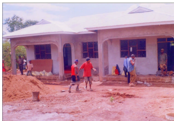
モシで建設が進んでいるレンタルハウスの外観
